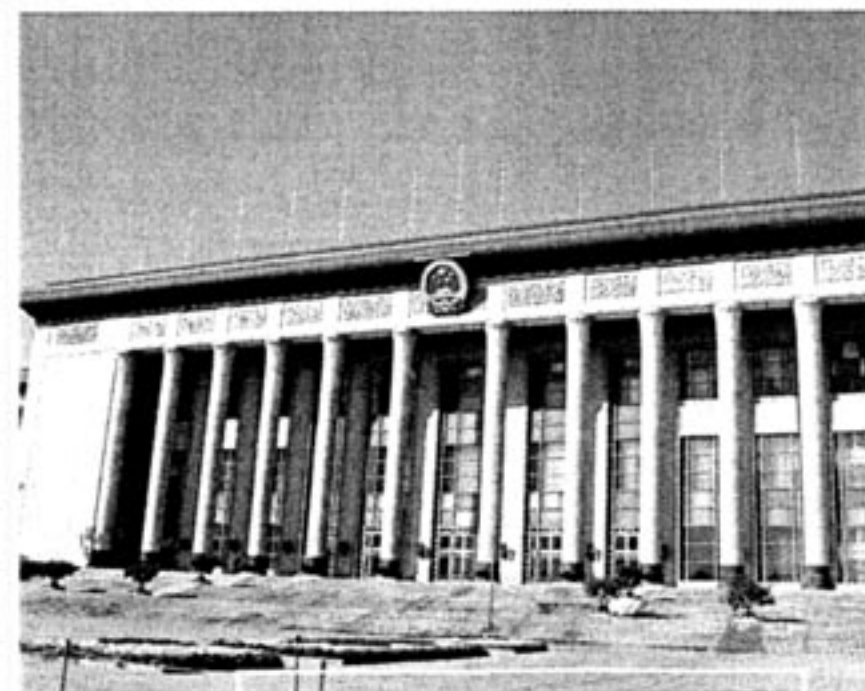
Il palazzo che ha ospitato l'incontro
